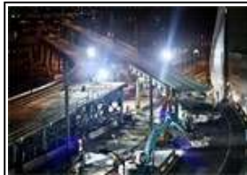
Het Alaskan Way Viaduct (Copyright: WSDOT)
