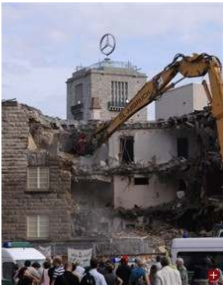
Wird auf jeden Fall teuer: Bauarbeiten am Nordflügel des Stuttgarter Hauptbahnhofs
